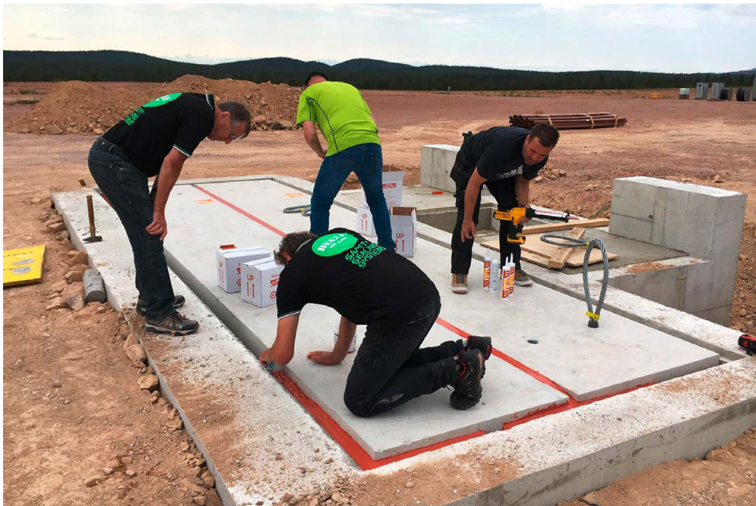
Bild 2: Einbau der Fugenabdichtungen.
